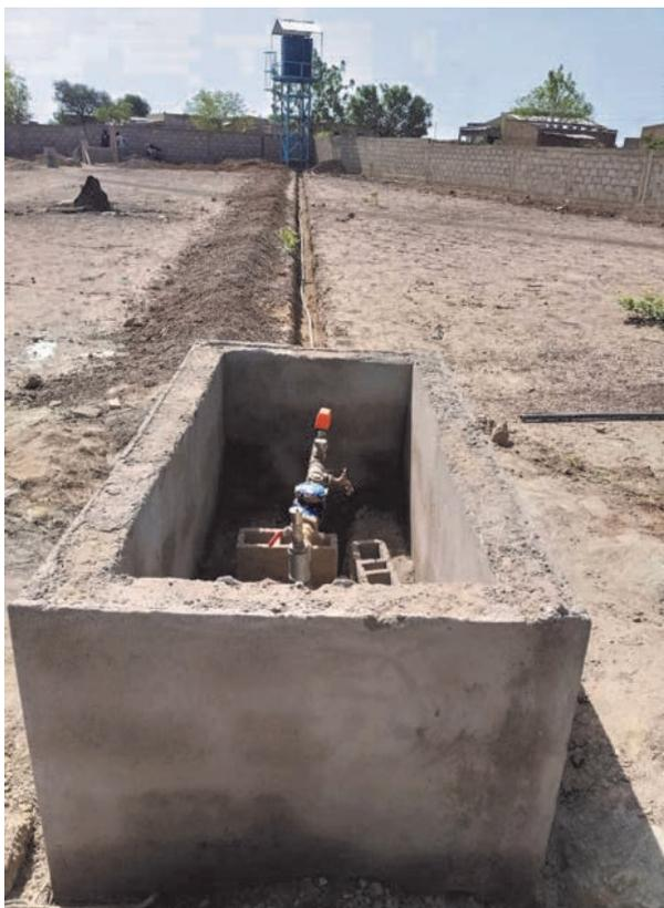
*La tête de forage avec le raccordement à la réserve d'eau*
